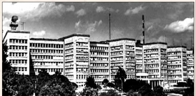
➔ Frankfurt/Main IG Farben Gebäude, 1949 – 1953 mit Frankfurt ACC im obersten Geschoss CPS-5 Radaranlage noch ohne IFF, 230 NM Reichweite bis 65.000 Fuss Höhe
