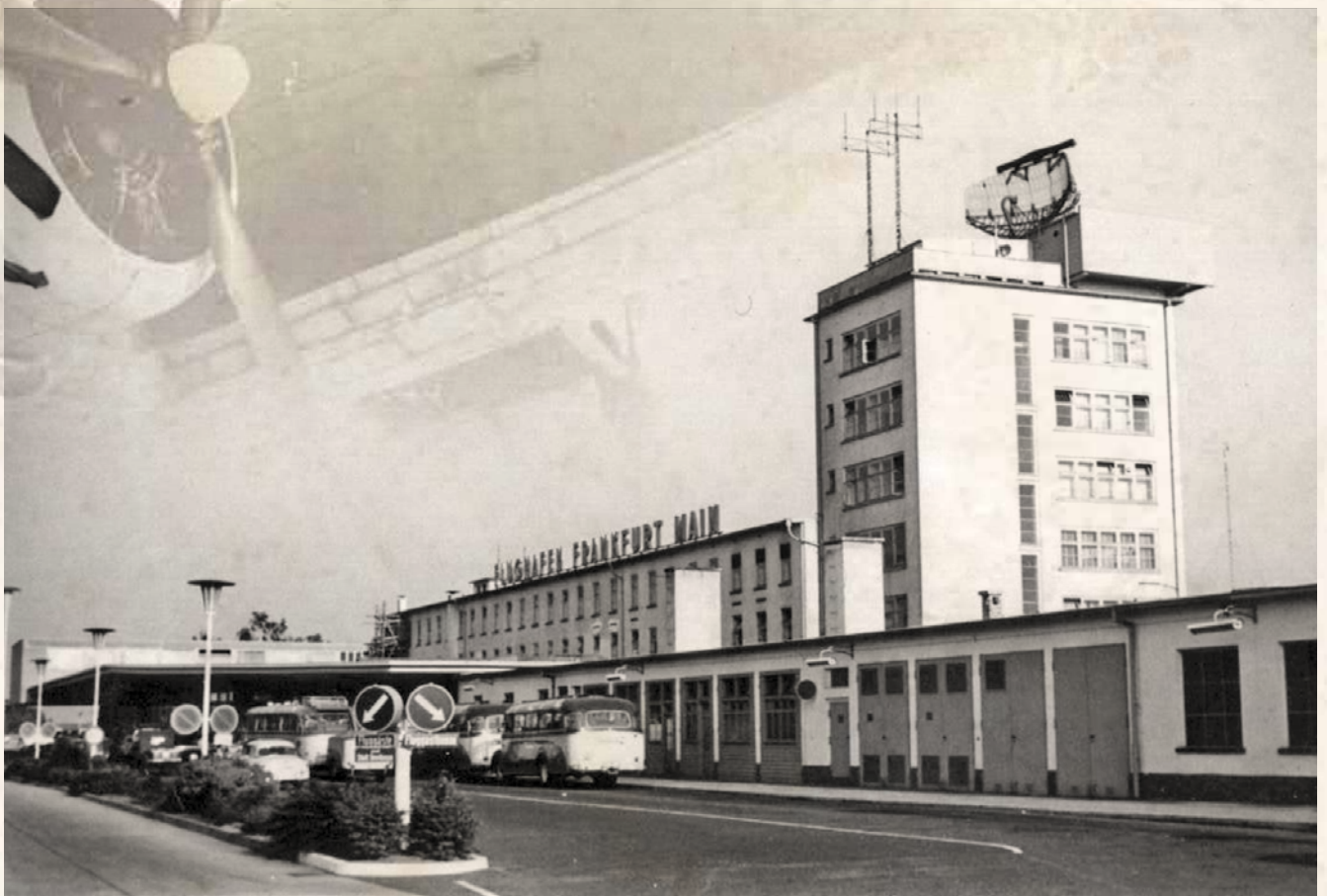
➔ Frankfurt ACC am Rhein-Main Flughafen ab April 1953; seit 1955 auf dem Dach die CPS-5 Radaranlage vom IG-Hochhaus, jetzt mit IFF; Die Anlage wurde später wieder demontiert Photo: FAG
